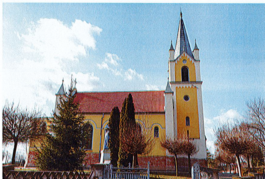
Prace konserwatorskie przy drzwiach głównych w kościele parafialnym p.w. Wszystkich Świętych w Gluszyńce Fot. UM Namysłów
